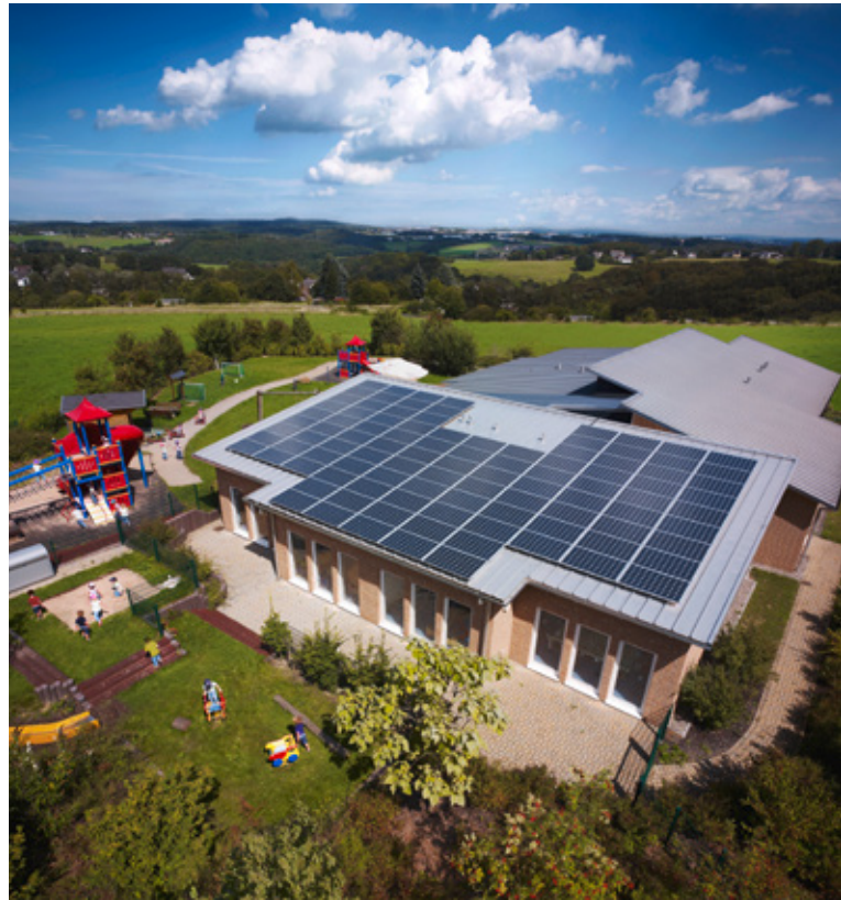
100 SolarWorld-PV-Module auf dem Dach der Kita Kalenborn in Rheinland-Pfalz sparen im Jahr 9,7 Tonnen Treibhausgase, 17,6 Megawattstunden Strom werden erzeugt
