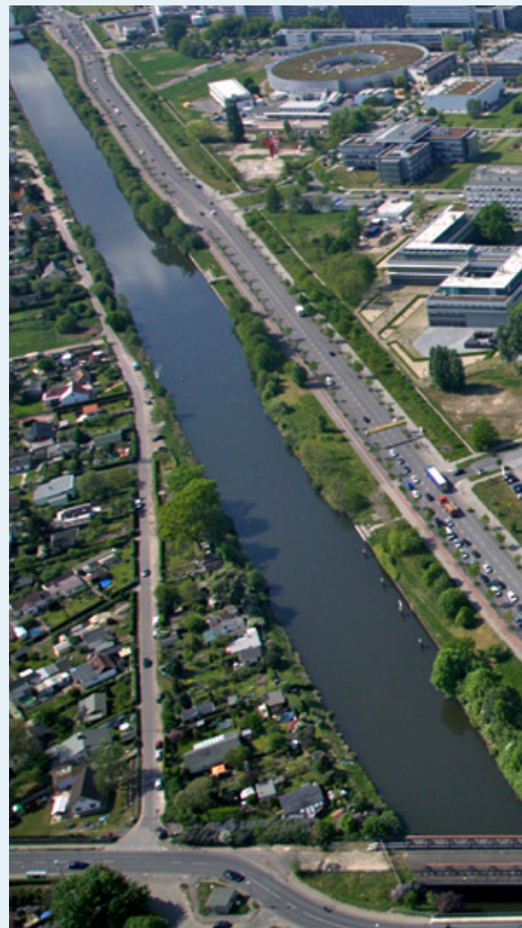
Luftaufnahme Berlin Adlershof
